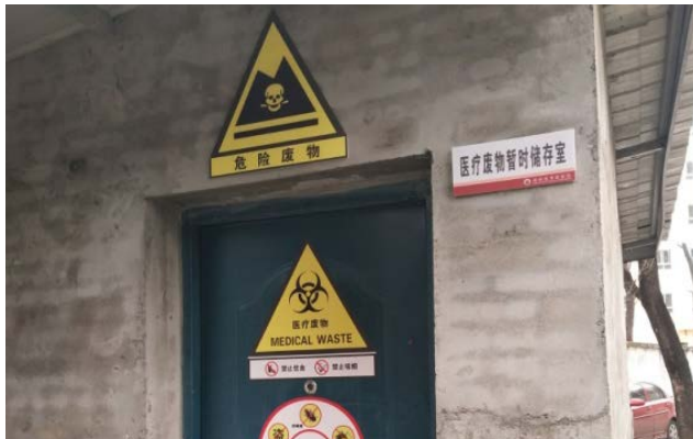
图1-7 医疗废物暂存间标识标牌
