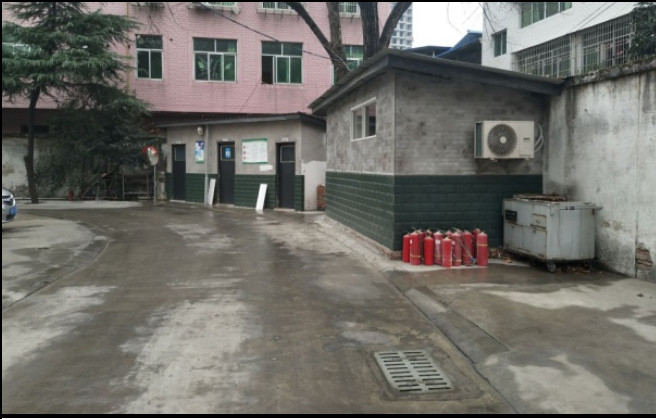
图1-15 医疗废物暂存间外灭火器材
