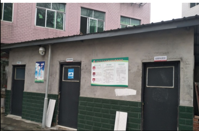
图1-13 医疗废物暂存间外管理室
