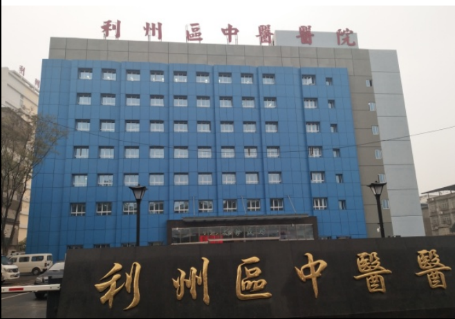
图1-5 项目已建门诊楼
