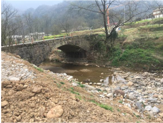
图3-1 项目所在地北侧麻柳沟
