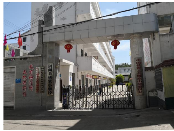
图 3.2-10 姚家乡小学现场实景图
