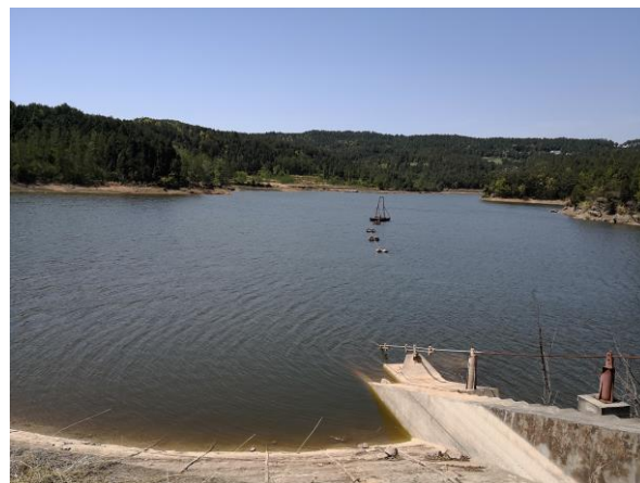
图 3.2-8 高台水库现场实景图
