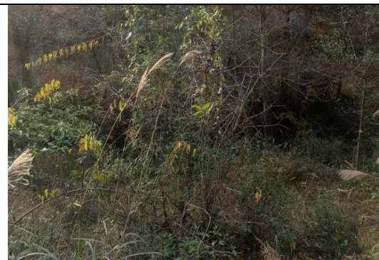
杨家河水库坝址处现状 2
