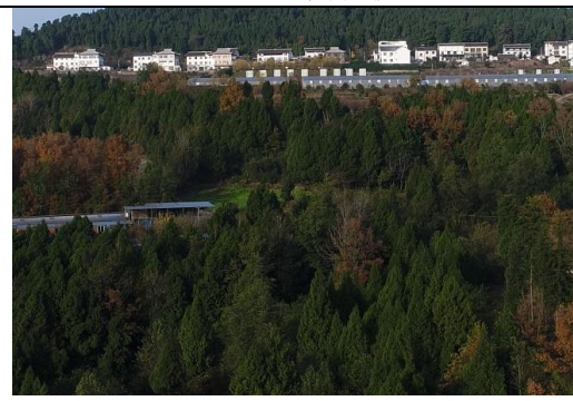
坝址北侧居民现状
