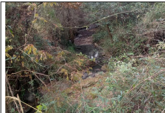
杨家河水库坝址处现状 1
