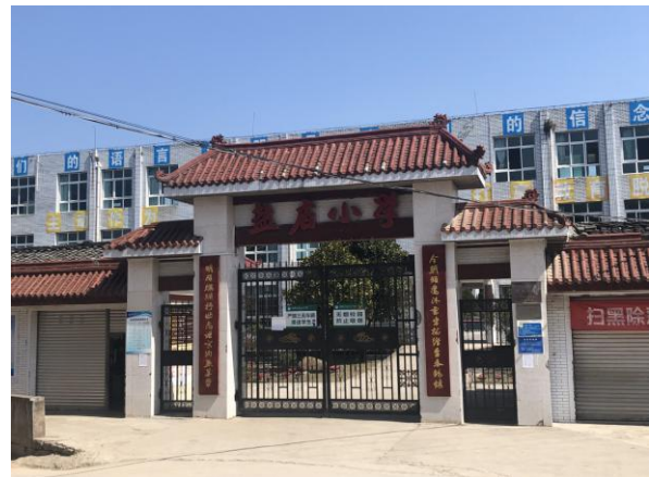
图 3.2-10 盐店镇中心学校现场实景图
