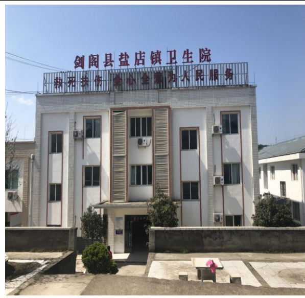
图 3.2-8 盐店镇卫生院现场实景图
