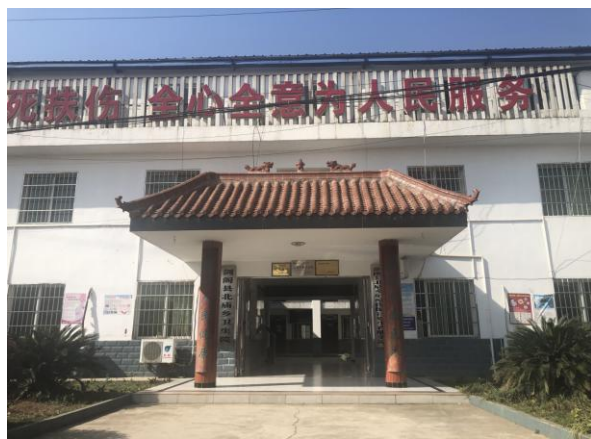
图 3.2-9 石元乡卫生院现场实景图
