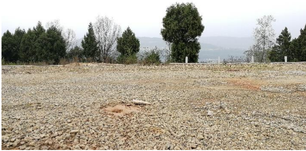
图 1-3 双探 7 井北侧现状
