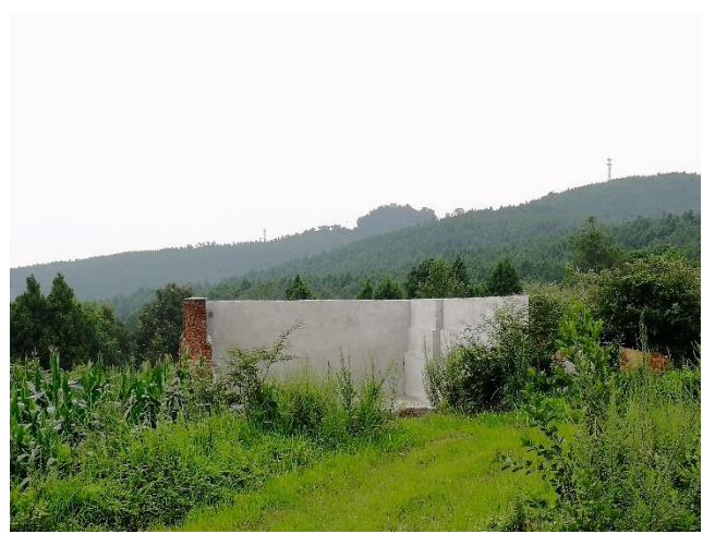
图 3.2-2 原双探 7 井放喷坑现状
