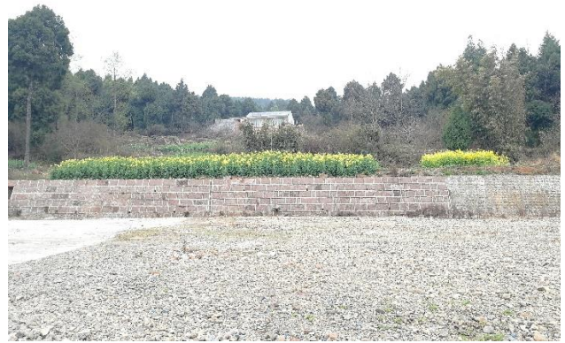
图 1-2 双探 7 井西侧现状
