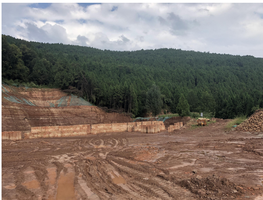
图2.2-2 矿山开采现状（照片）
