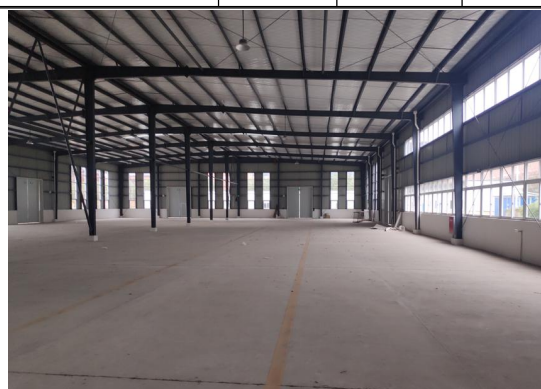
项目厂房现状空置、地面已硬化
