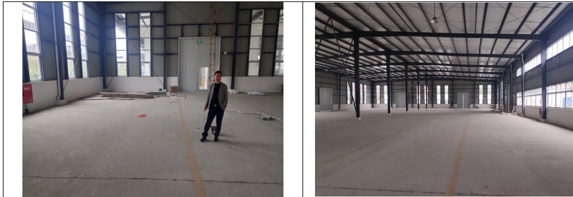
项目厂房现状空置、地面已硬化
