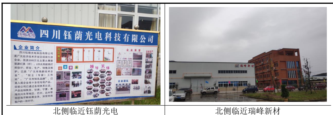
图 1-3 项目现状照片
