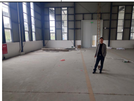
项目厂房现状空置、地面已硬化
