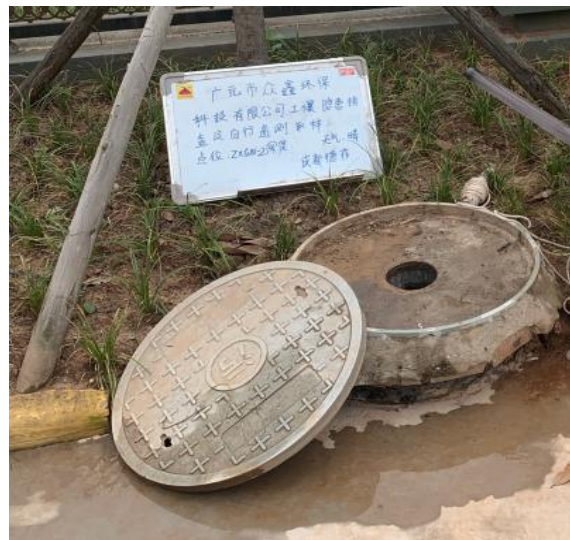
图3-6：地下水监测井
