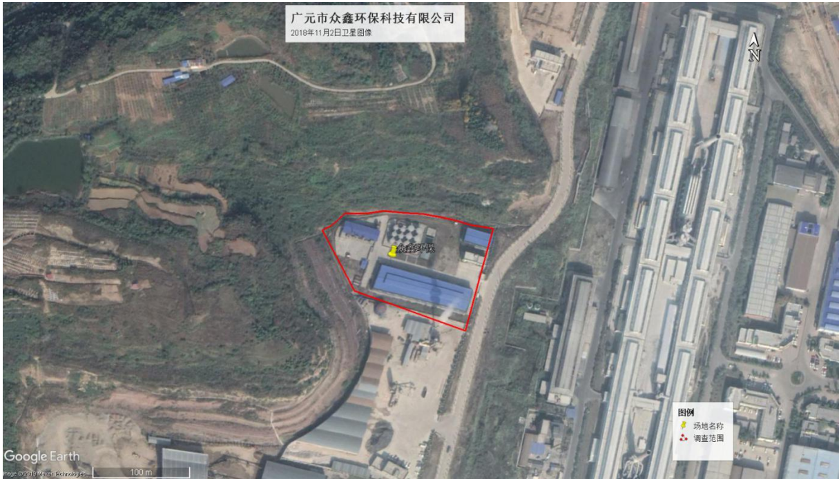
图 2-4：2018 年 11 月厂区卫星影像图
