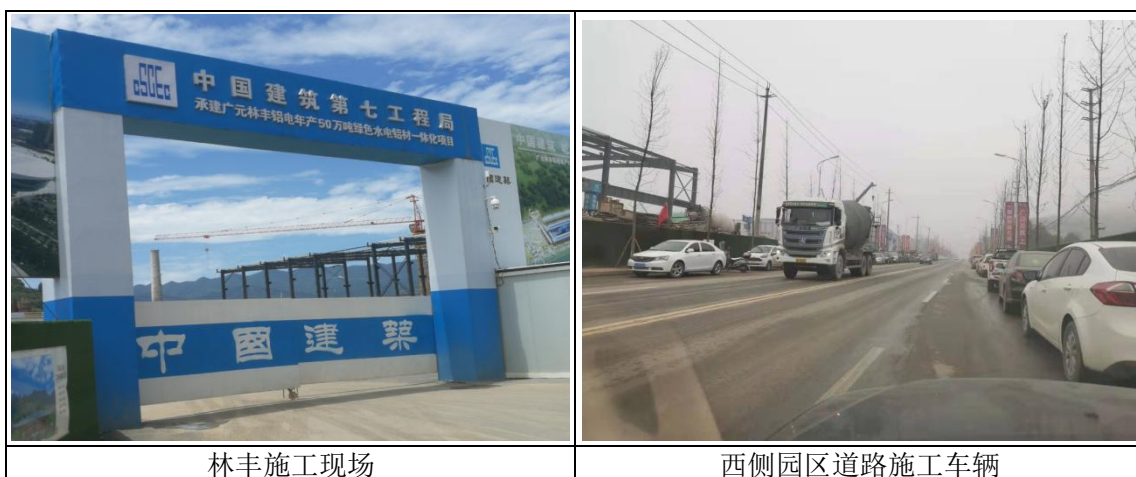
图 5-3 周边施工现状照片
