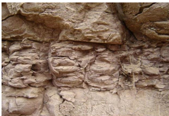
图 4-5 岩层中的微小层间裂隙
