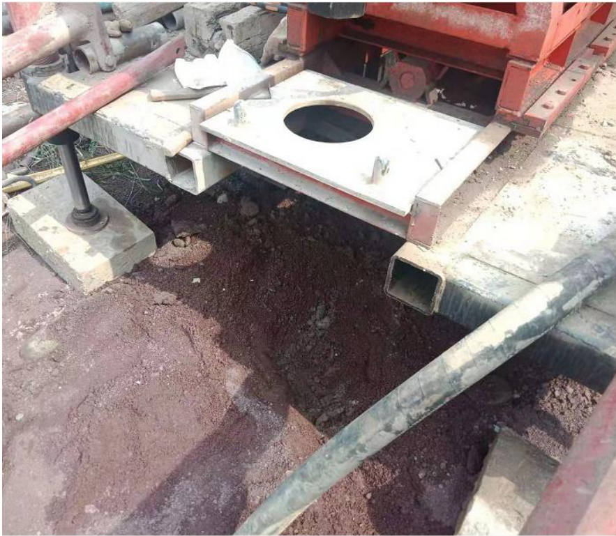
地下水打井照片
