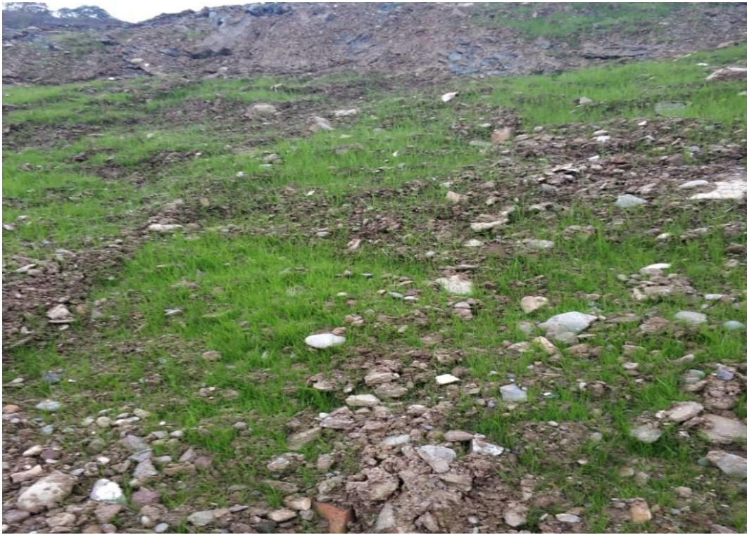
图 2.12-1 矿山已复垦边坡
