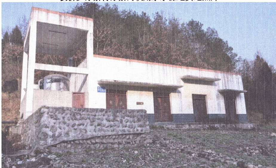
板桥乡供水站实地照片
