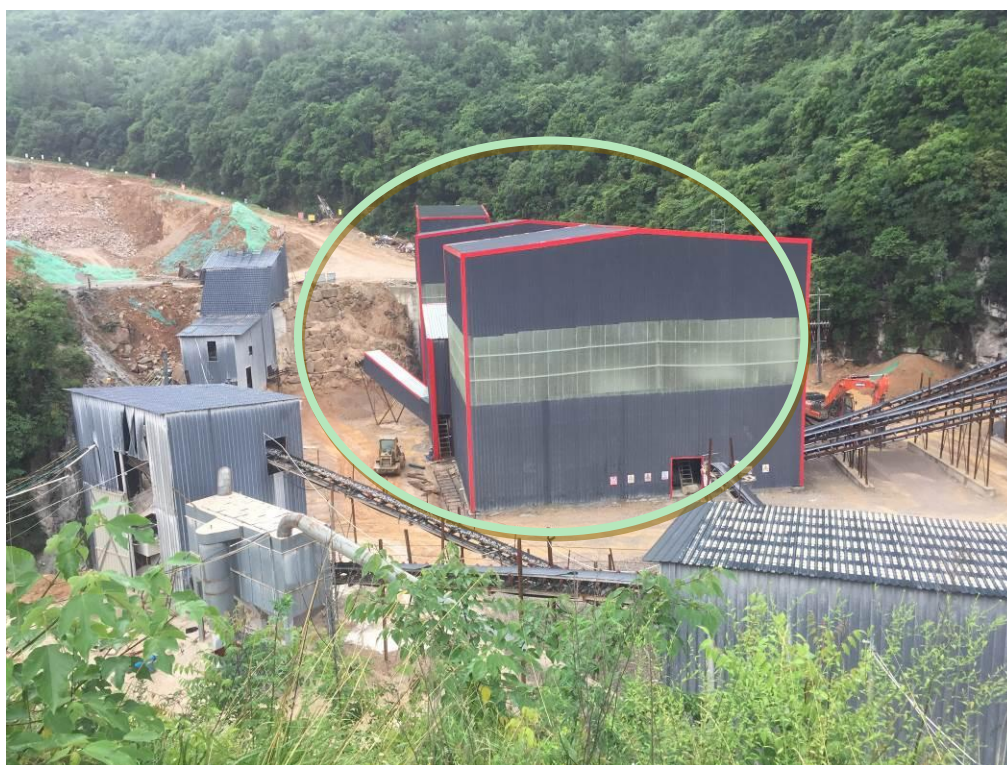
图 5-7 新建破碎生产线封闭厂房
