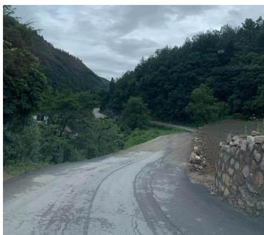
图3-1 项目入场运输道路
