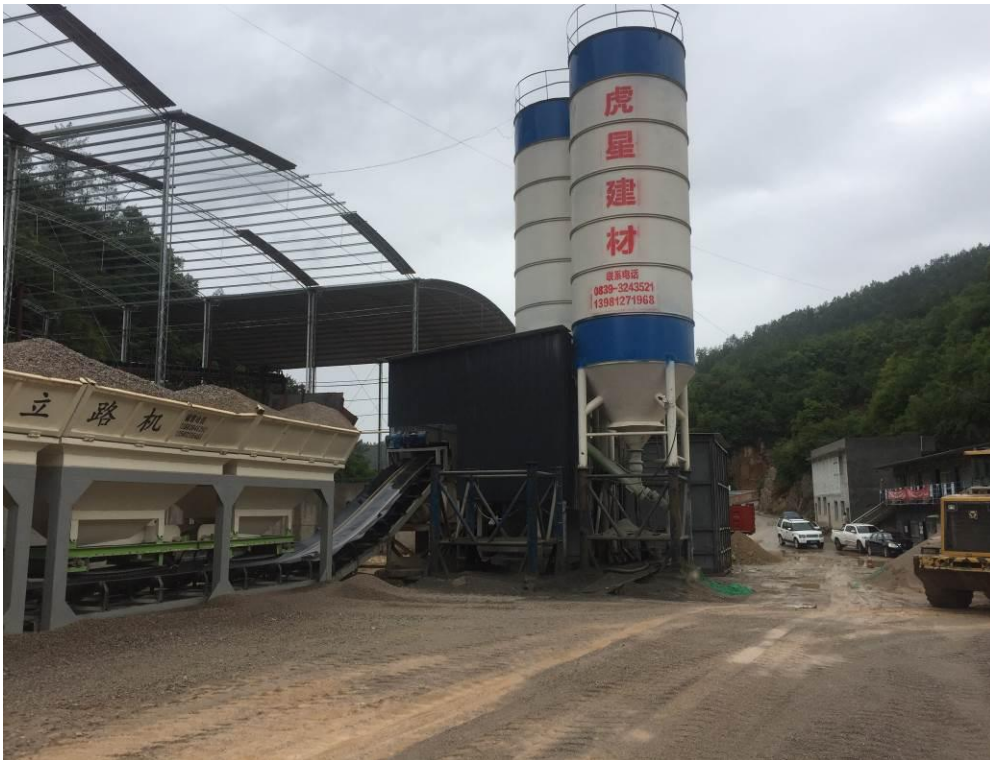
图 5-12 水稳料生产线搅拌设备
