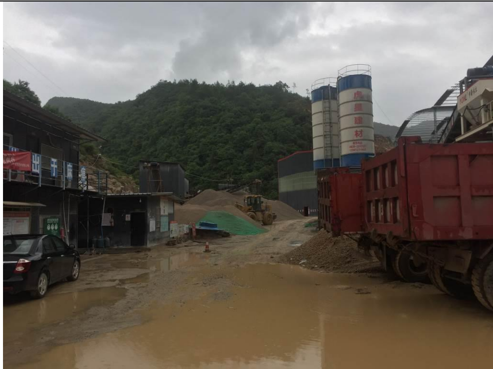
图 5-6 厂区内雨水散排情况
