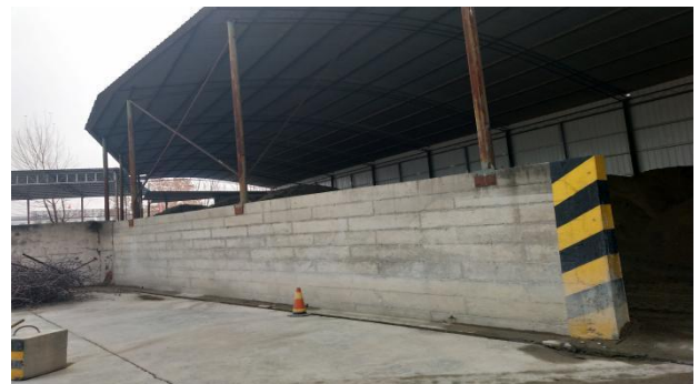
砂浆砂堆料场
