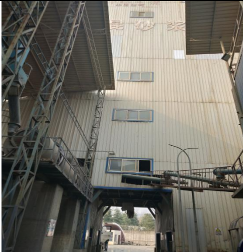
密闭砂浆搅拌站
