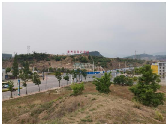
项目地内部弃方
