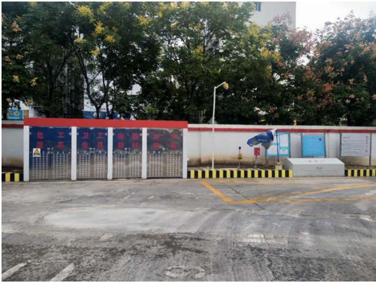
危险废物暂存间
