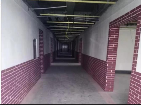
综合楼（原办公用房内部）
