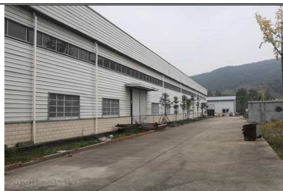
拟建康复中心（原制衣车间外部）
