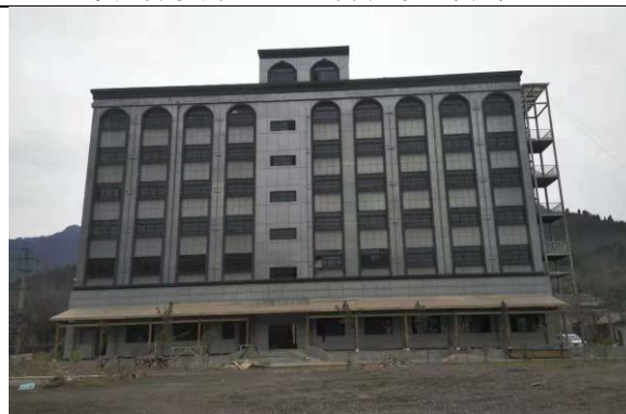
综合楼（原办公用房外部）
