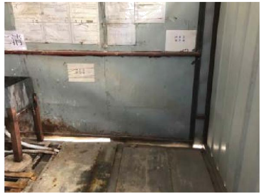
初级沉淀池+调节池
