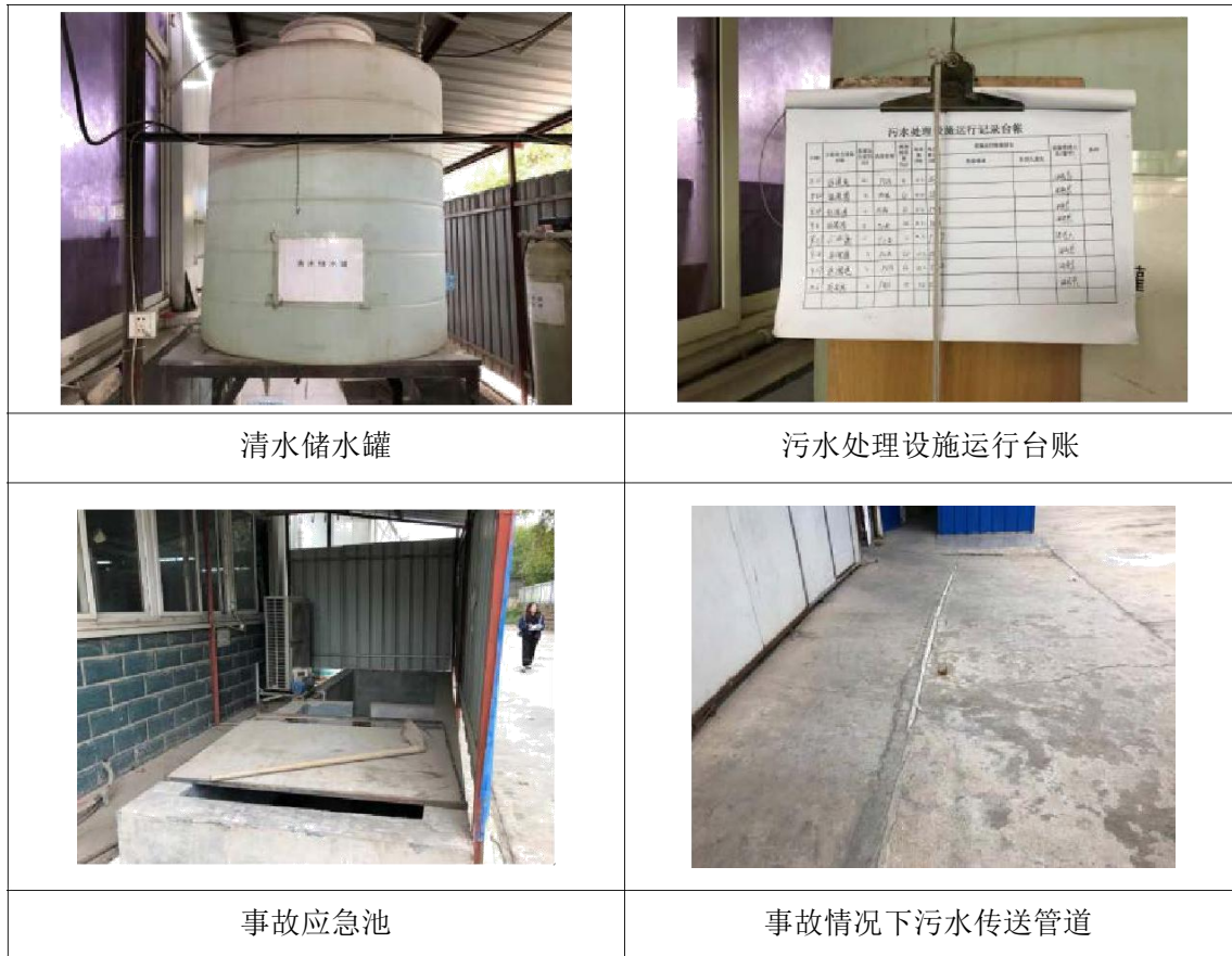
图 3-6 厂区现场照片
