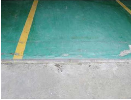
存储库房门口围堰
