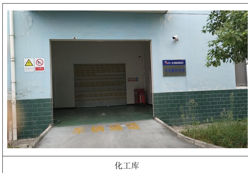
图 1-3 厂区现状照片
