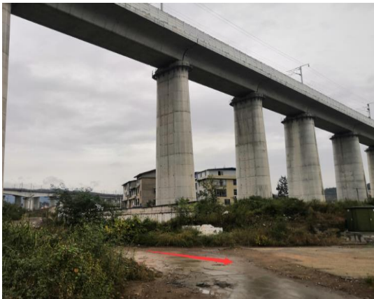
下穿西成客专段道路（已实施）
