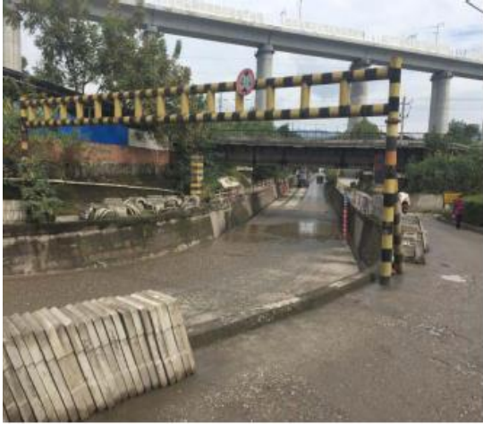
下穿铁路处现状近照
