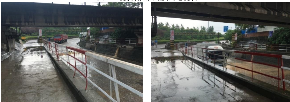
图 2-3 现状利州西路及下穿铁路通道
