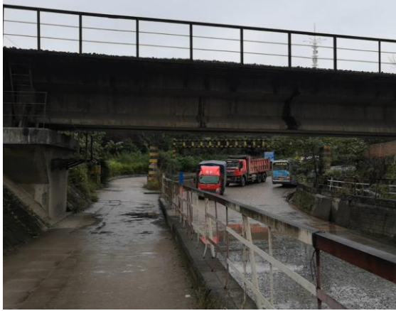
下穿铁路处梁体现状道路
