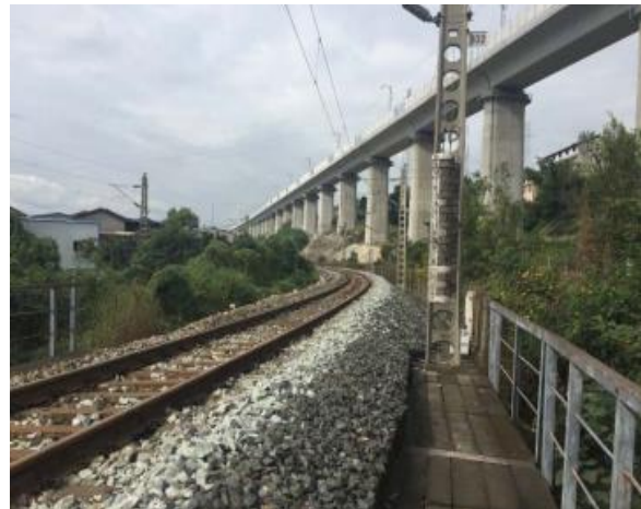
下穿铁路处铁路路基照片
