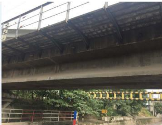
下穿铁路处梁体近照
