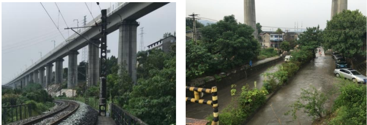
图2-5 现状西成高速铁路
