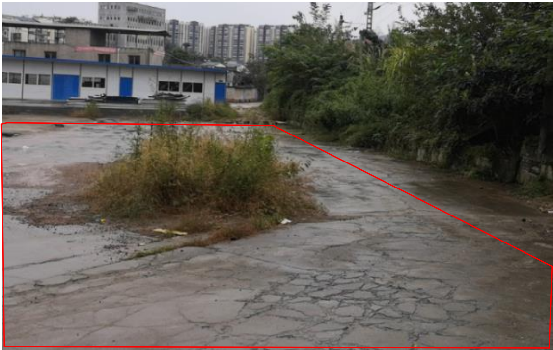
图1-10 项目临时施工场地现场图
