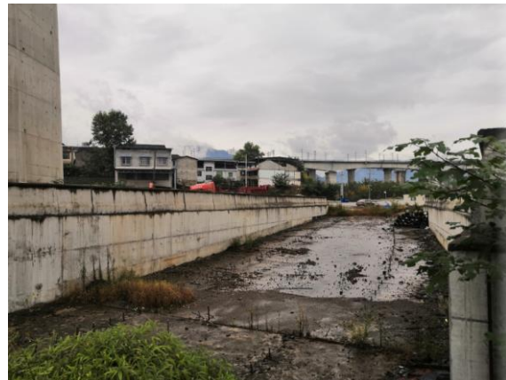
下穿西成客专段道路（已实施）
