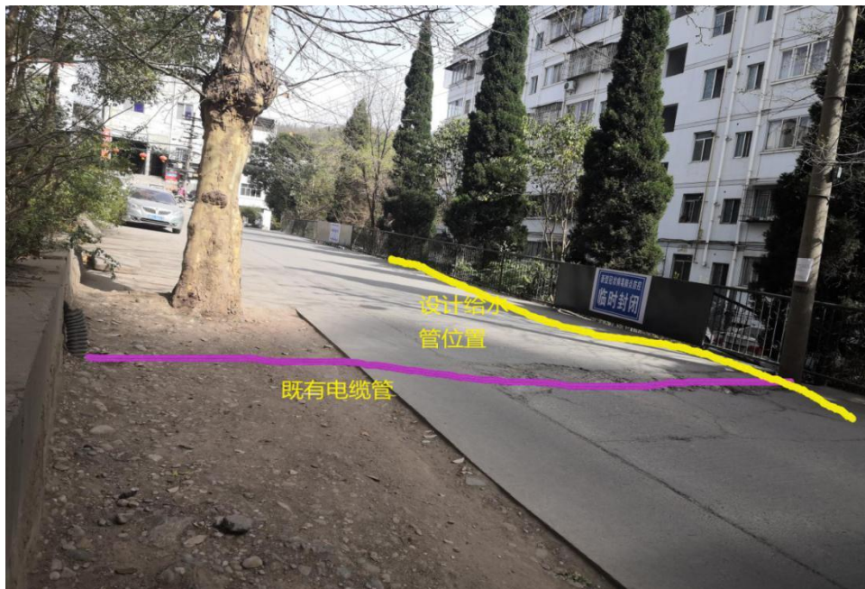
图 5-5 电缆穿越段
