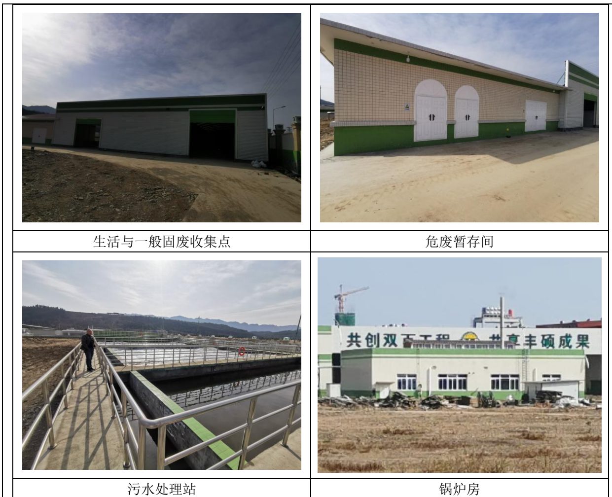
图 1-1 广元市吉香居食品有限公司一期工程现状
