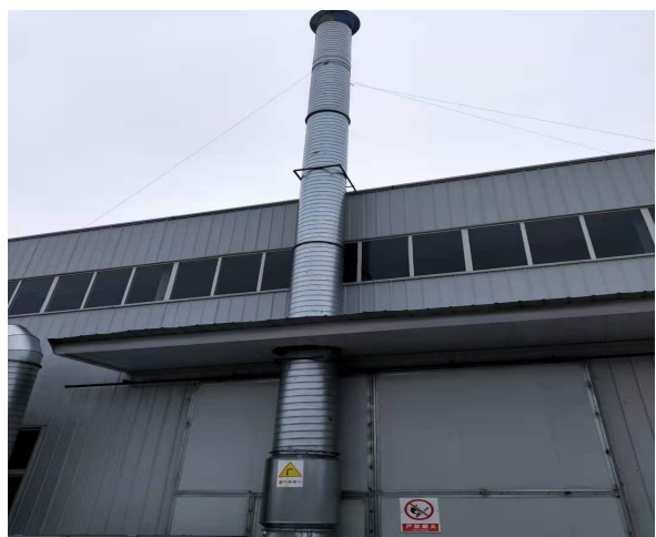
有机废气排气筒（P1）
