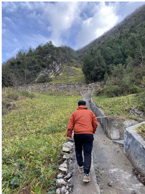
图 7.2-2 原 2#弃渣堆排水沟（右下方即为农田）
