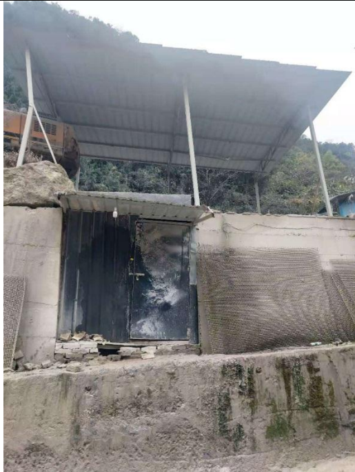
现状柴油储存间
