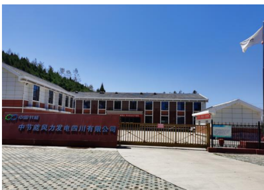
一期工程生活区
