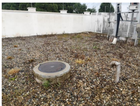
1#主变事故油池
