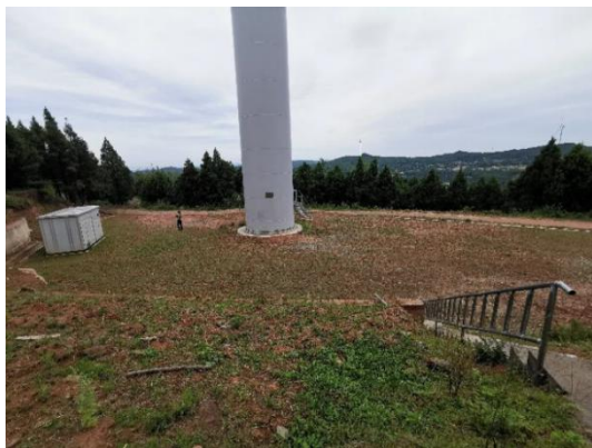
一期风机基础恢复现状
