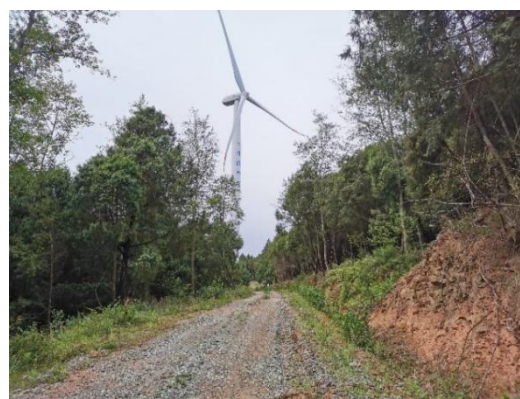
一期进场道路现状
