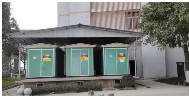
项目用房北侧
