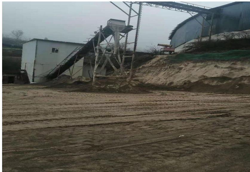
图 5-11 项目后续加工区生产现状图
