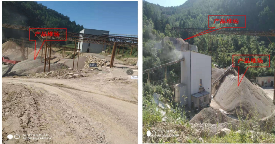
图 5-13 项目后续加工区生产现状图
