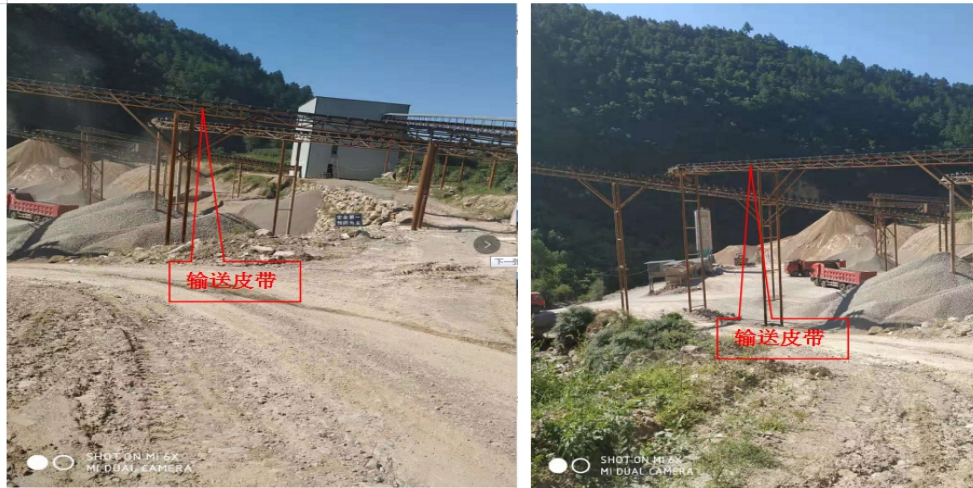
图 5-12 项目后续加工区生产现状图
