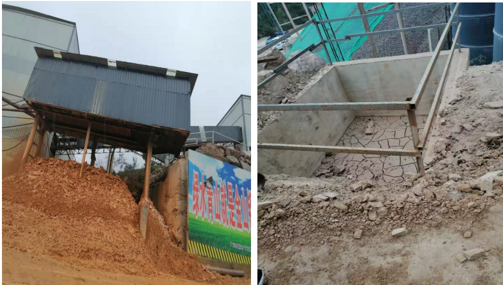
图5-20 项目后续加工区洗砂废水沉淀池污泥暂存现状图
