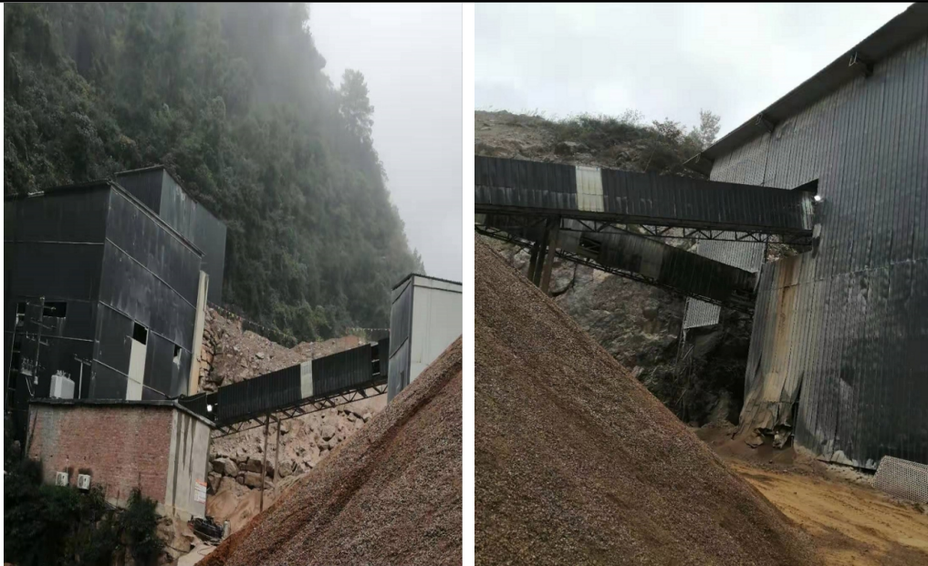
图 5-7 项目矿区配套粗加工区皮带输送带现状图
