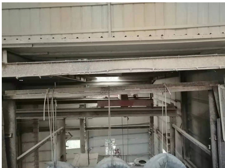
图 5-5 项目矿区配套粗加工区卸料口现状图
