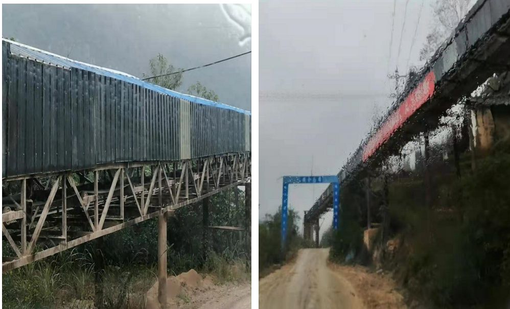
图 5-9 项目矿区配套皮带输送廊道现状图
