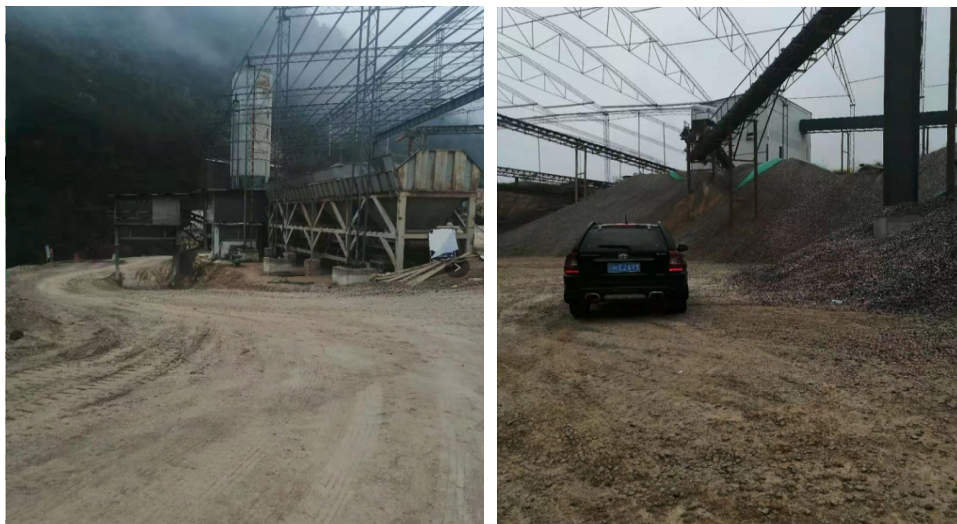
图 5-15 项目后续加工区生产厂房搭建现状图
