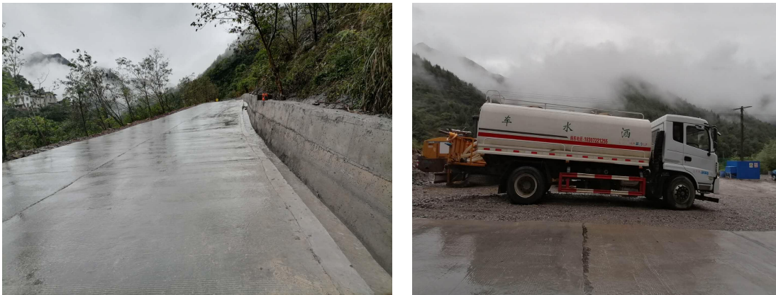
图 3-3 破碎站至水泥厂区运矿道路及道路两侧降尘措施图
