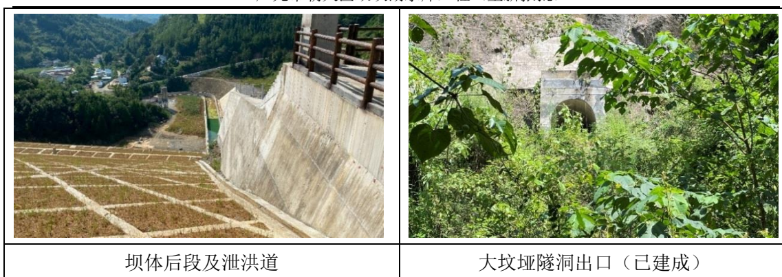
图 3-2 工程建设现状照片
