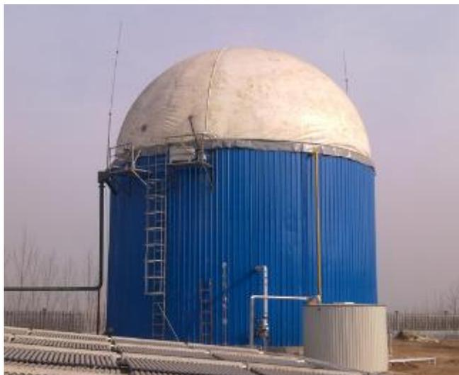
图 3-5 双膜储气袋示意图
