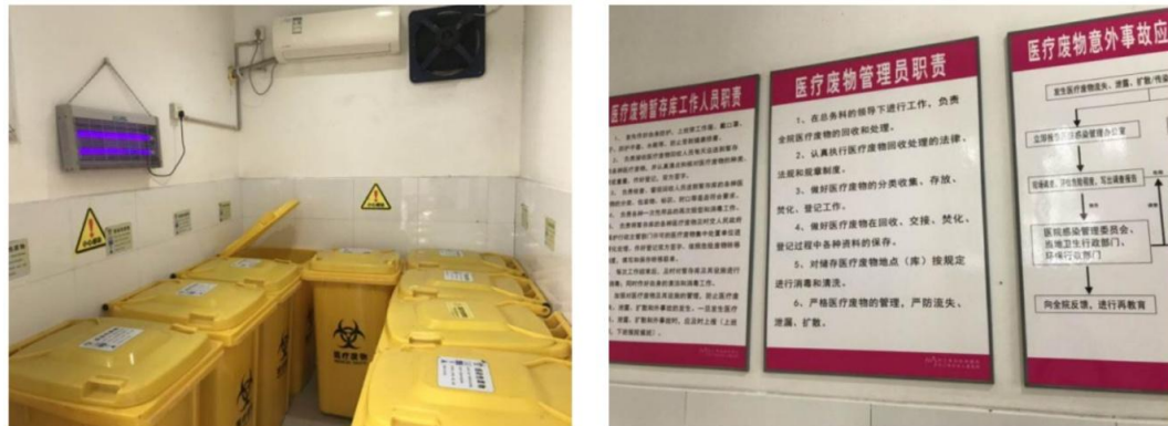
图 4-3 医院危险废物暂存间
