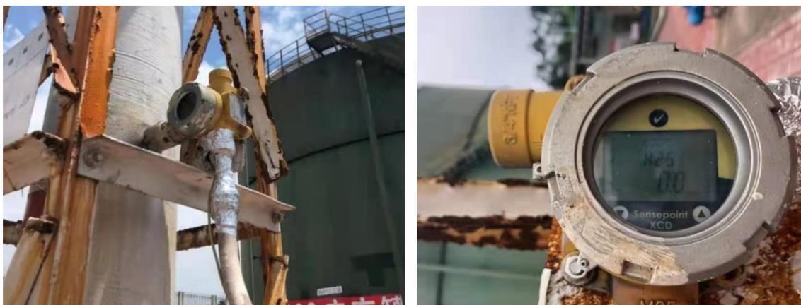
图 3.2-4 空间除硫装置排气筒及硫化氢检测装置图片
