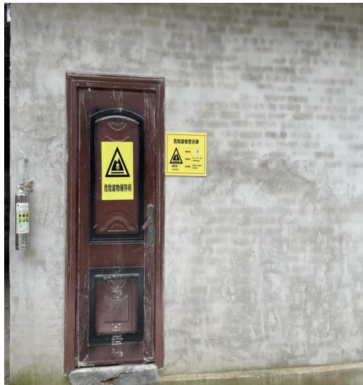
危险废物暂存间
