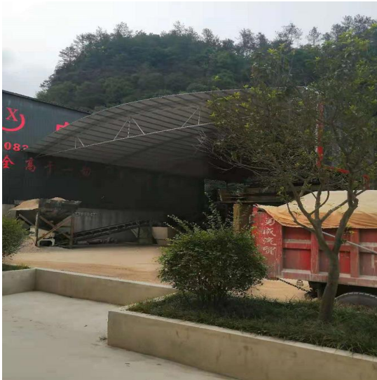
生产车间现状
