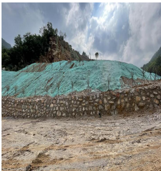
排土场防尘网、挡墙和生态恢复
