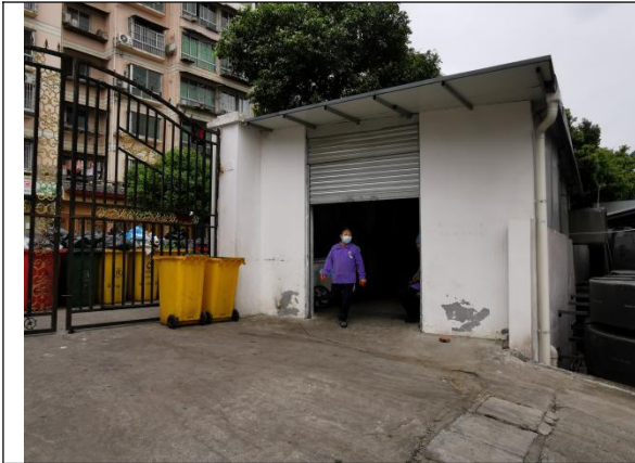
生活垃圾暂存间
