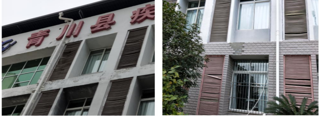
图 2-13 业务楼外貌现状照片
