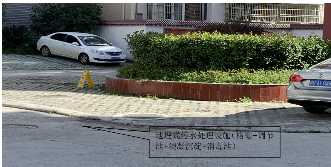
图 2-18 污水处理设施现状照片
