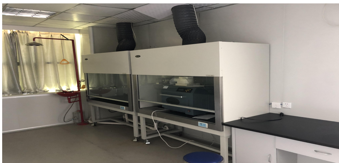
图 2-20 原项目废气处理设施 1
