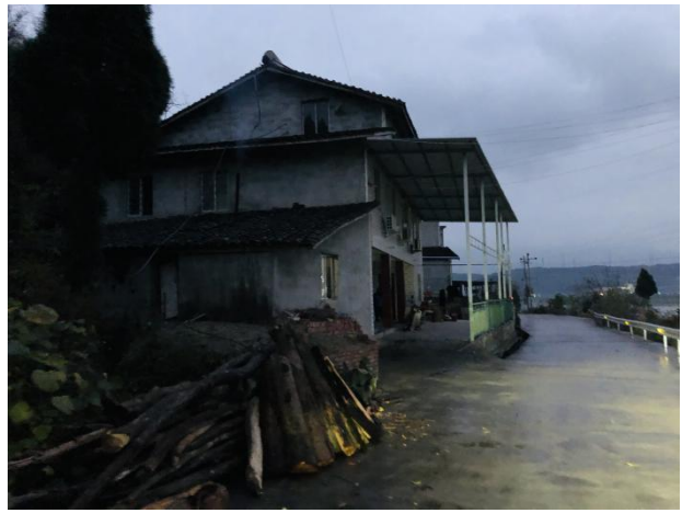
利州区盘龙镇先锋村2组成安勇住宅
