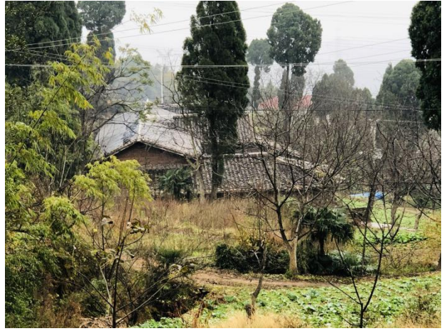
昭化区射箭镇塔子村1组侯福勇住宅
