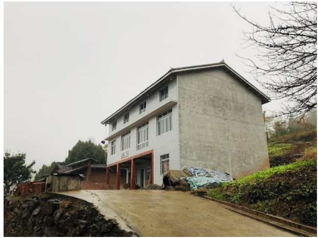
利州区龙潭乡春风村7组吴树勇住宅
