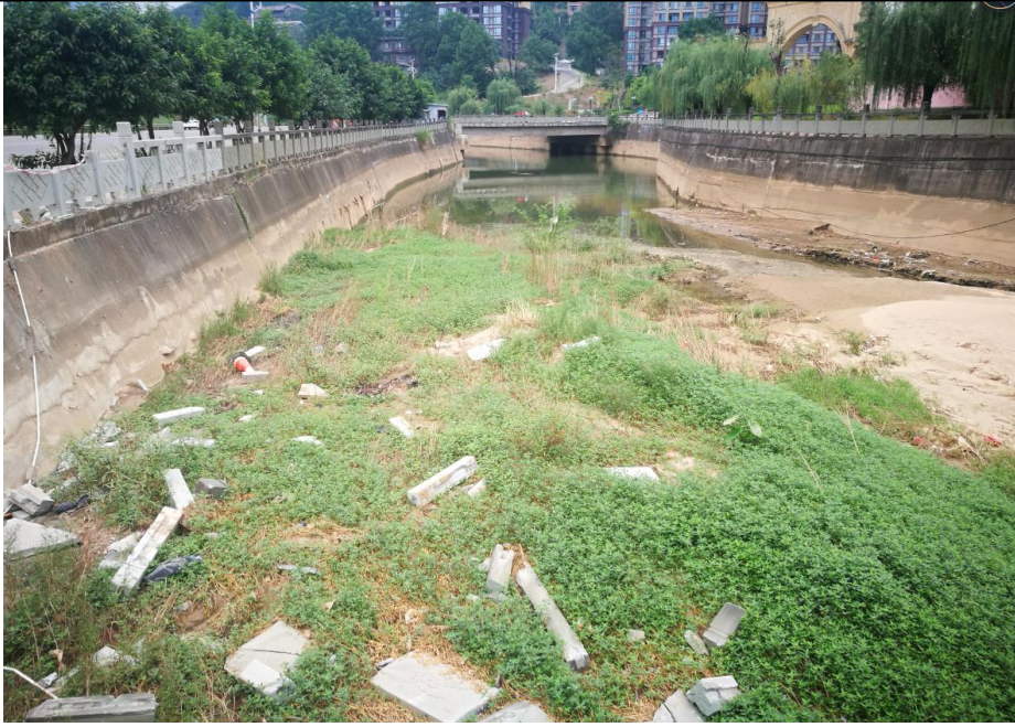
项目 K0+526.065~K0+631.678 段跨作坊沟现状
