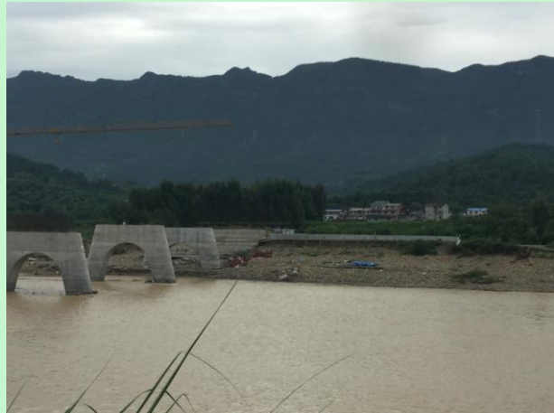
图 1-9 在建赤化大桥与项目交叉处
