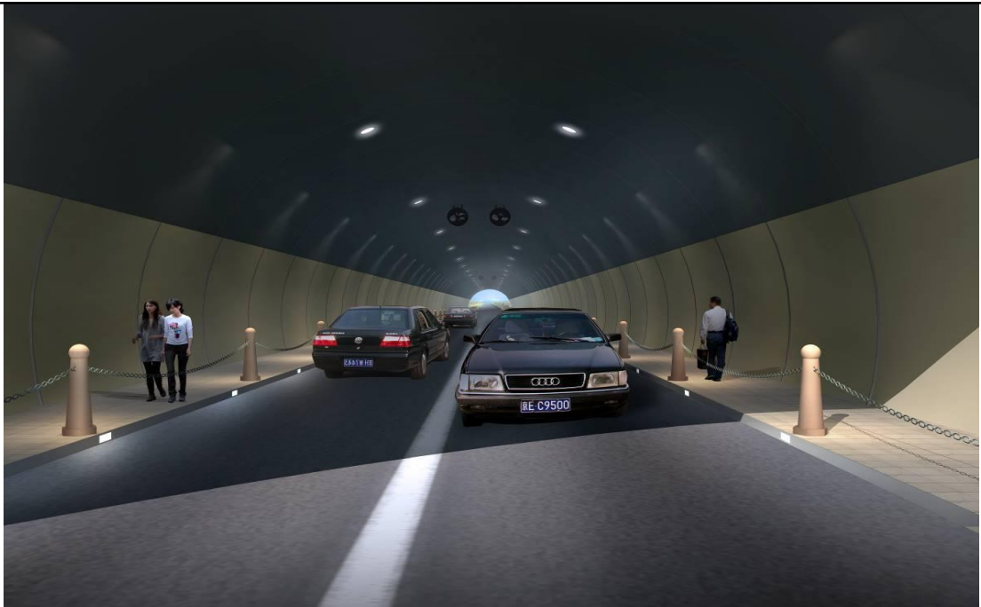
图 2-5 隧道洞内装饰图
