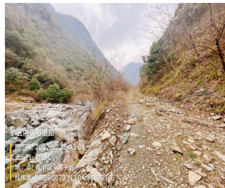
矿山道路现状
