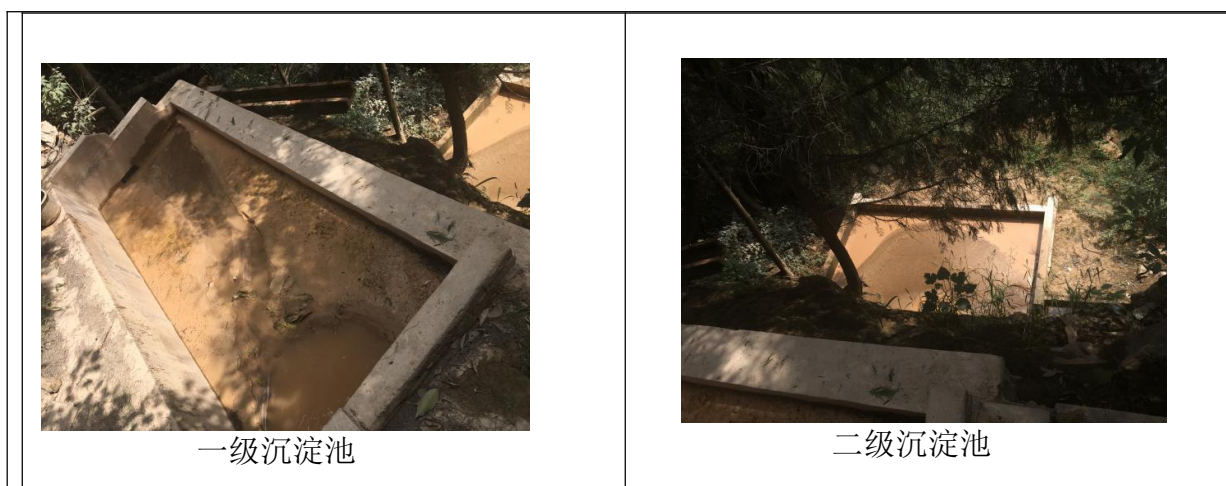
图5-2 沉淀池现场照片图
