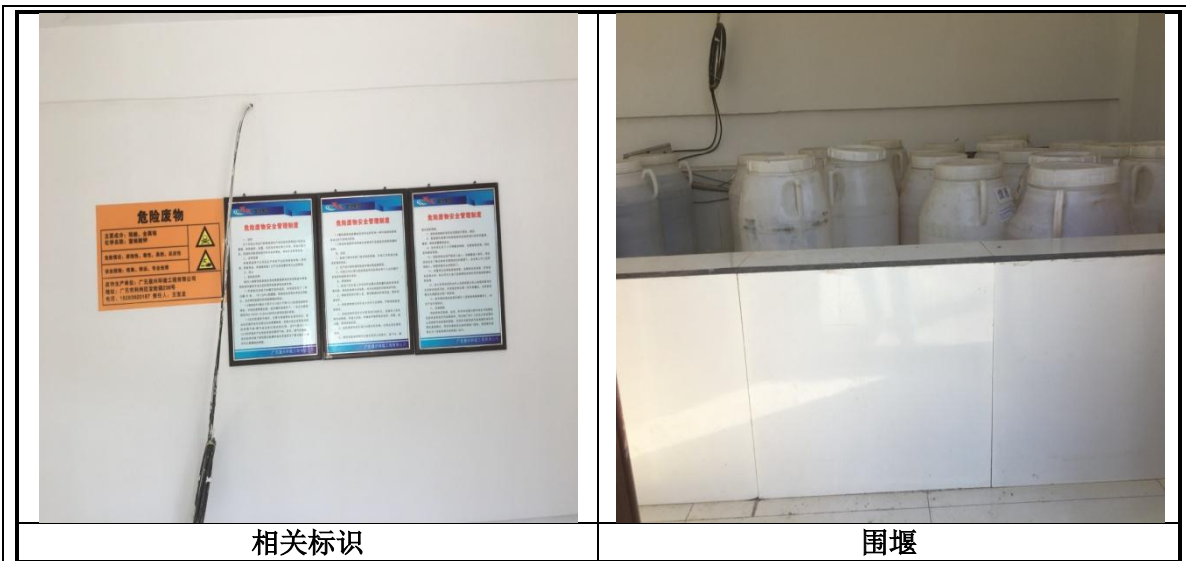
图 1.9-3 宝轮镇污水处理厂废液暂存间现状图
