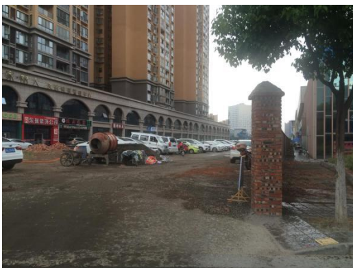
图 1-4 项目东二段现状照片
