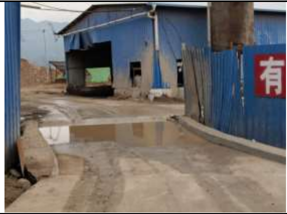
车辆冲洗水槽
