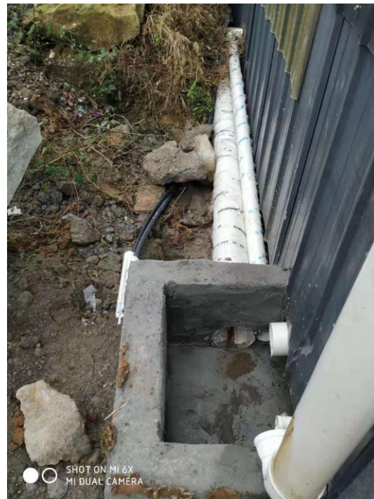
图三 项目地厂区北侧污水排污口
