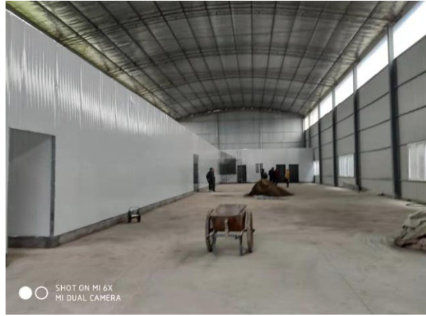
图一 项目地厂区内部现状
