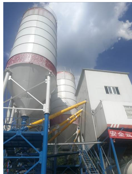
搅拌楼和筒仓
