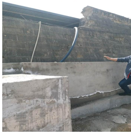
厂区废水与市政管网接口
