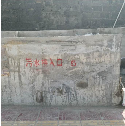
厂区内污水处理站
