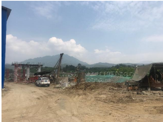
特大桥施工场地（1#钢筋混凝土拌合站）
