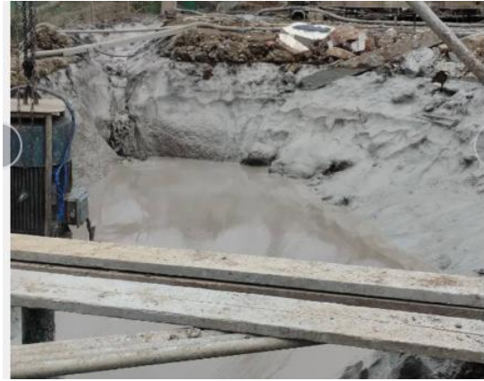
已经施工完毕小型沉砂池
